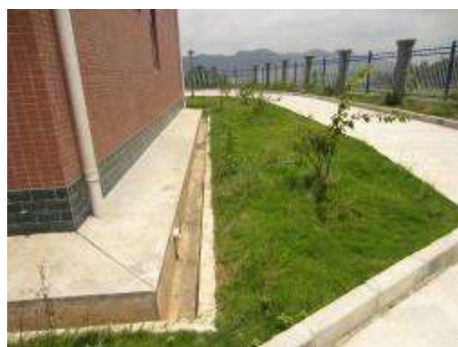
收费站房区排水沟
