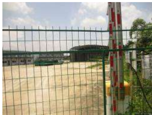
施工生产生活区（已移交）
