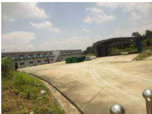
施工生产生活区（已移交）
