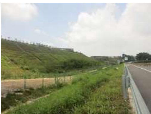
施工道路现状
