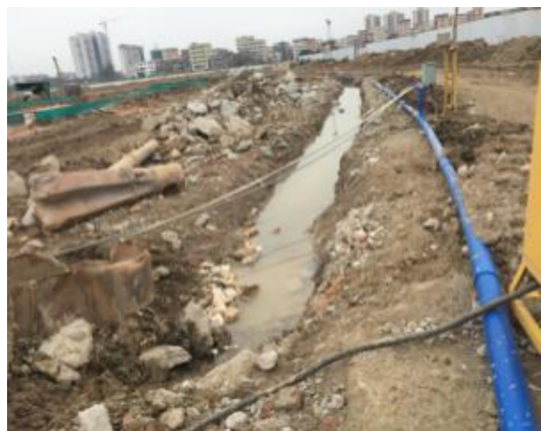
项目区南侧临时排水沟
