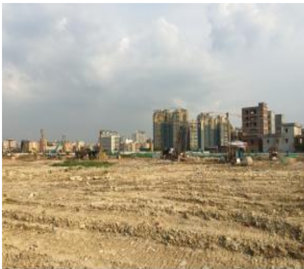
项目施工现场
