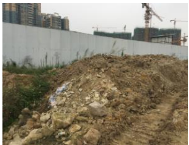
项目区南侧临时堆土
