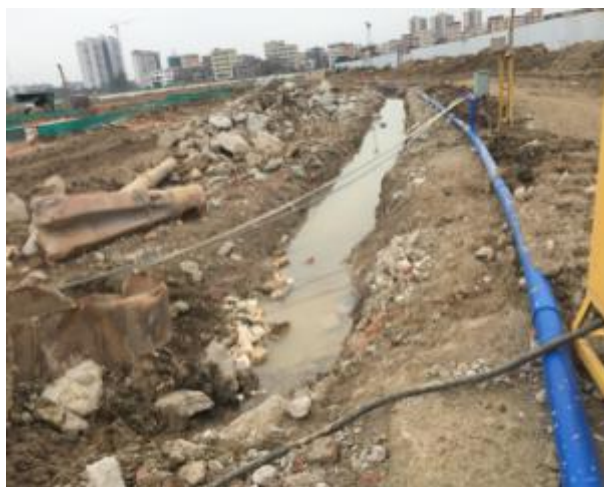
项目区南侧临时排水沟
