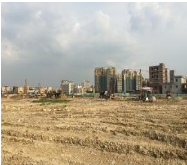
项目施工现场
