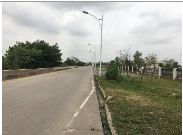
12、南侧堤路现状
