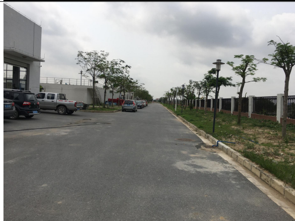
7 西侧道路现状
