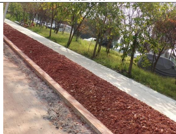
绿化覆土裸露现状（2018.12）
