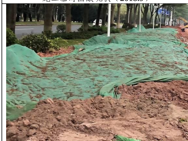
采用塑料薄膜临时覆盖的裸露地表现状 (2018.9)
