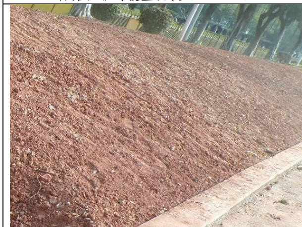
绿化覆土裸露现状（2018.12）
