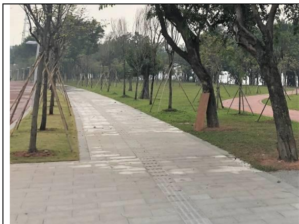
已完成施工的路面现状 (2018.9)
