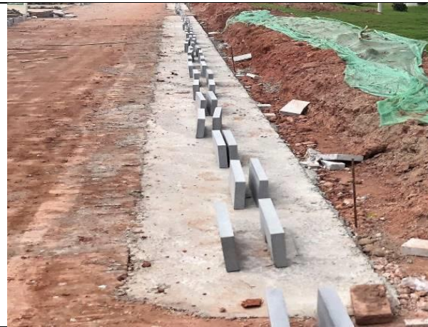
场地内部土质排水沟现状 (2018.9)
