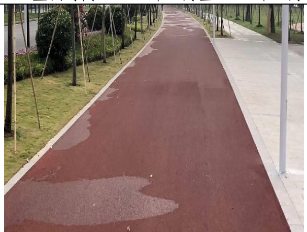
已铺设彩色沥青路面现状 (2018.9)
