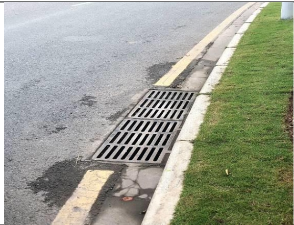
周边的市政雨水管网现状 (2018.9)
