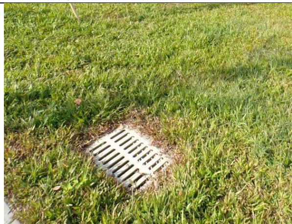
已布设生态排水沟现状（2018.12）
