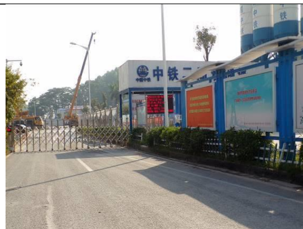
相邻工程施工场地现状（2018.12）
