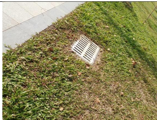
已布设生态排水沟现状（2018.12）
