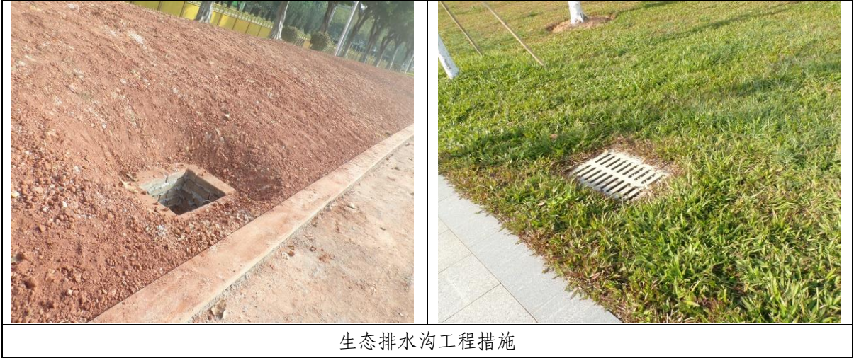
图 4-1 监测过程工程措施图
