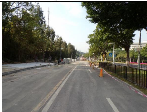
终点岭南印象园处施工现状（2019.3）
