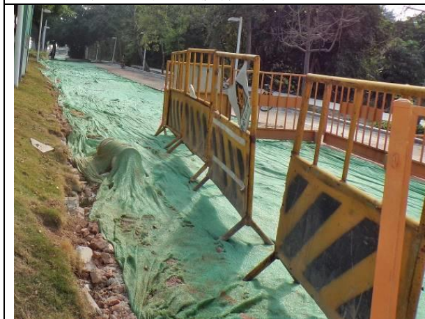
裸露面临时覆盖现状（2018.12）
