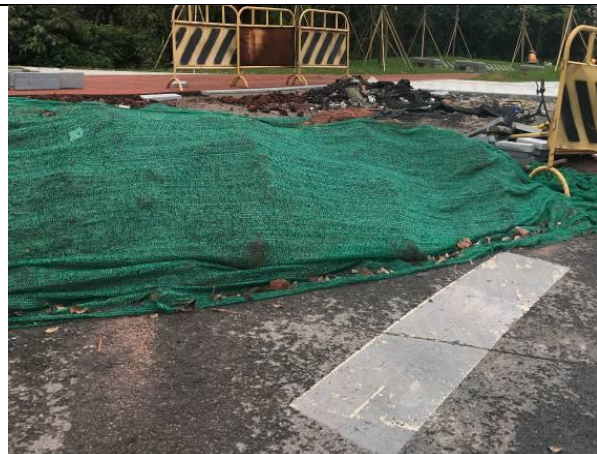
建筑垃圾临时覆盖现状（2019.3）
