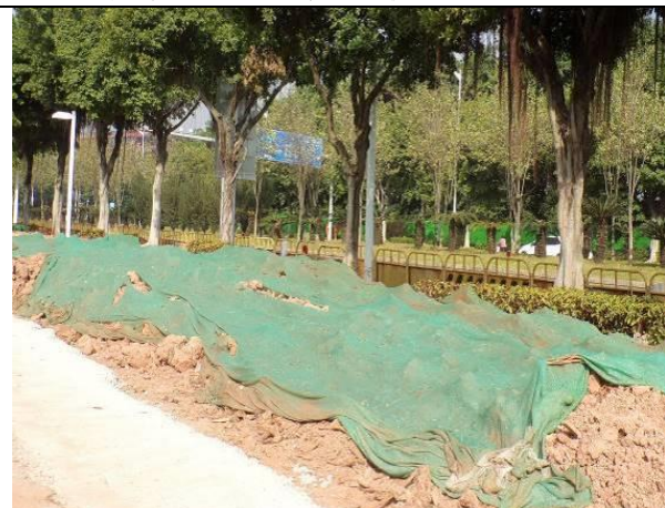
裸露面临时覆盖现状（2018.12）
