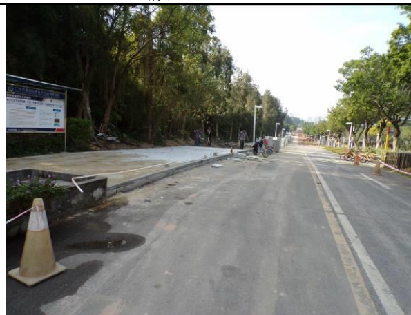
终点岭南印象园处施工现状（2019.3）
