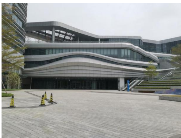
图 3 航站楼中部现状
