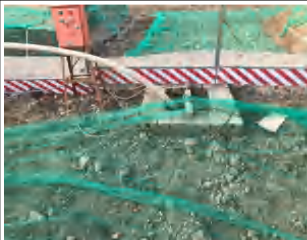
塑料彩条布苫盖+砖砌沉沙池
