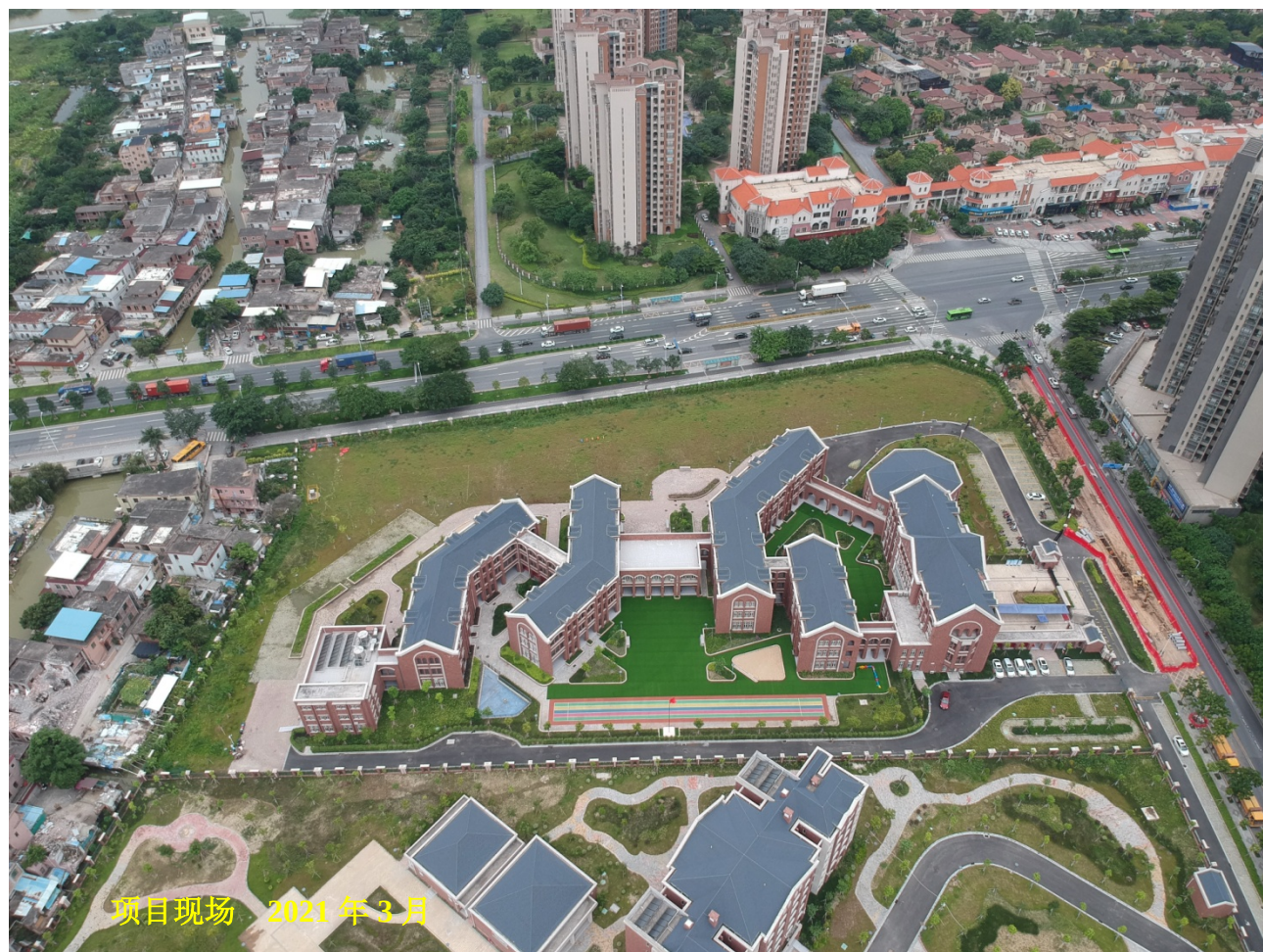
项目建设区 2021 年第一季度
