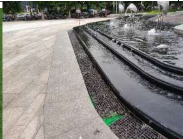
排水设施现状 4
