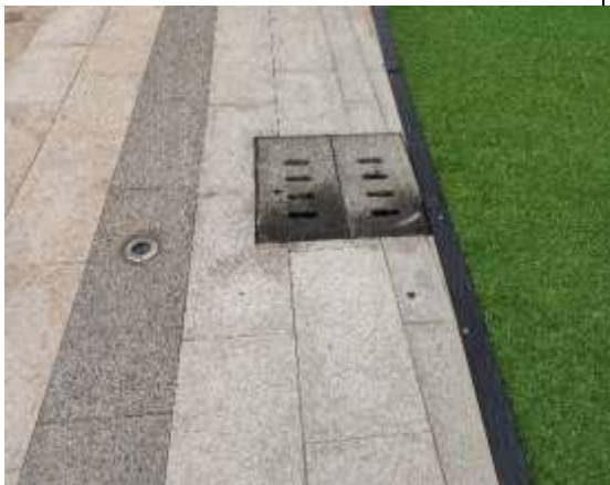
排水设施现状 3
