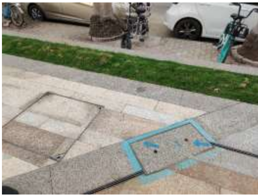
排水设施现状 1
