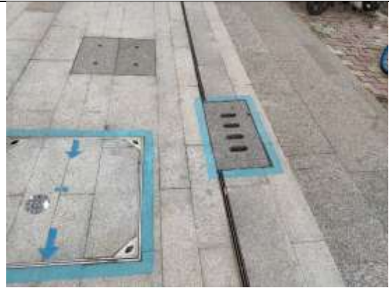
排水设施现状 2
