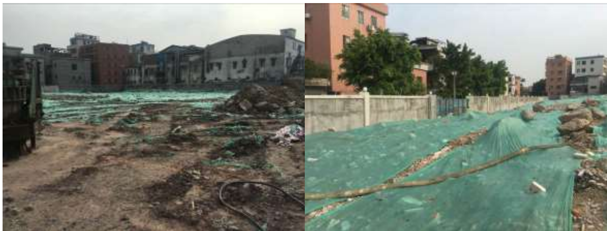
临时苫盖措施（施工准备期）
