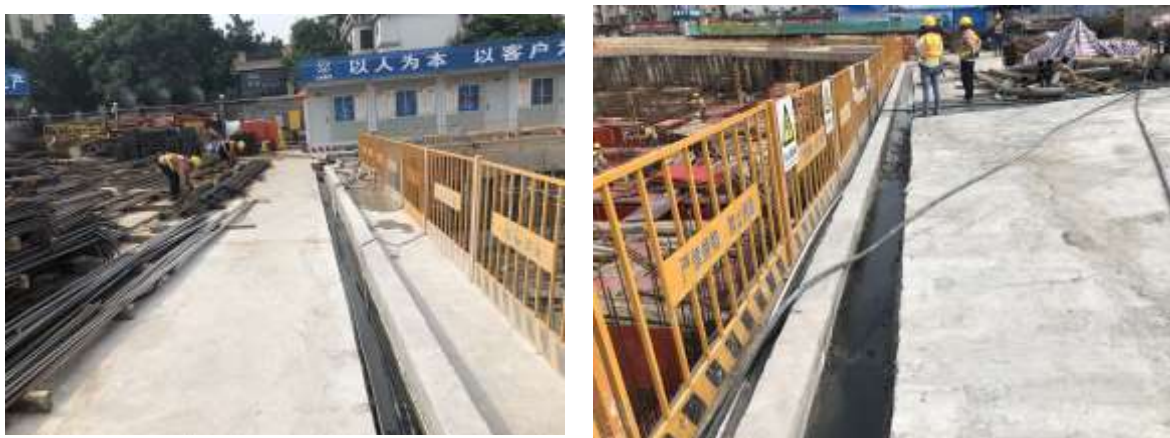
基坑顶部排水沟（基坑施工期）
