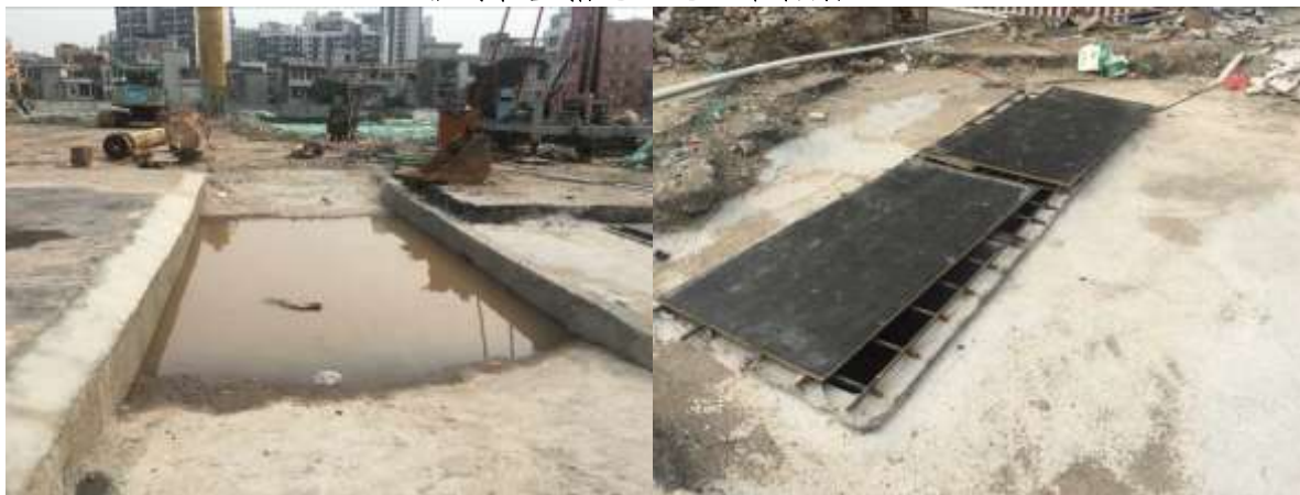
洗车池、沉沙池措施（施工准备期）
