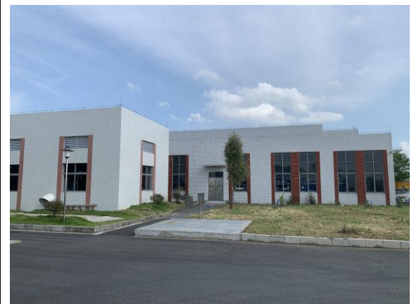
南侧建筑物及绿化现状
