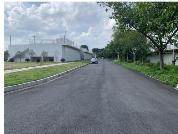
东侧道路现状
