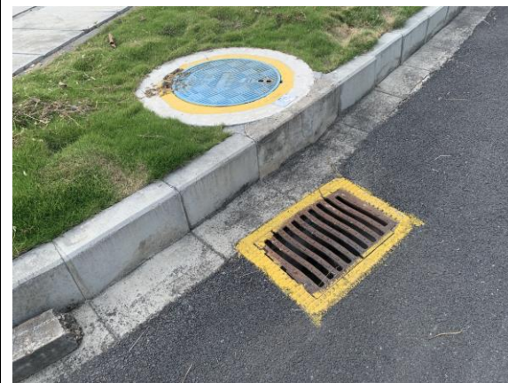
东侧排水管网现状
